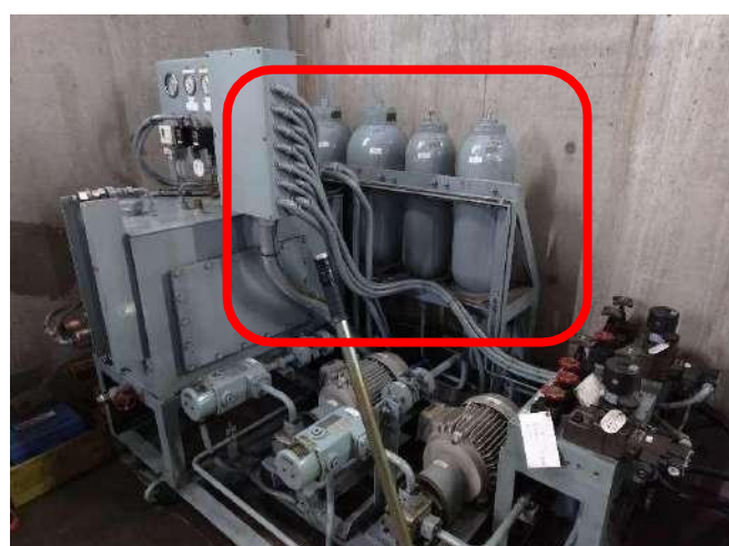
6-10 作動油に窒素ガスが混入する症状がみられたため 次年度はアキュムレーター(赤枠)の整備を実施予定
