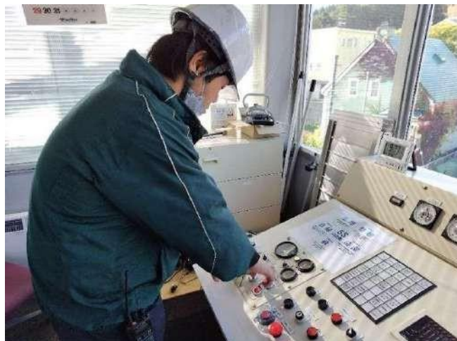
1-8 延線作業を行う際に使用するウインチが故障したため 当社の予備原動機を使用して延線作業を行った
