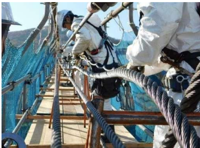
1-9 スプライスの編み込み作業
