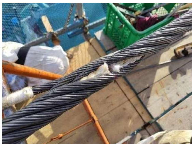
1-10 スプライスの編み込み作業
