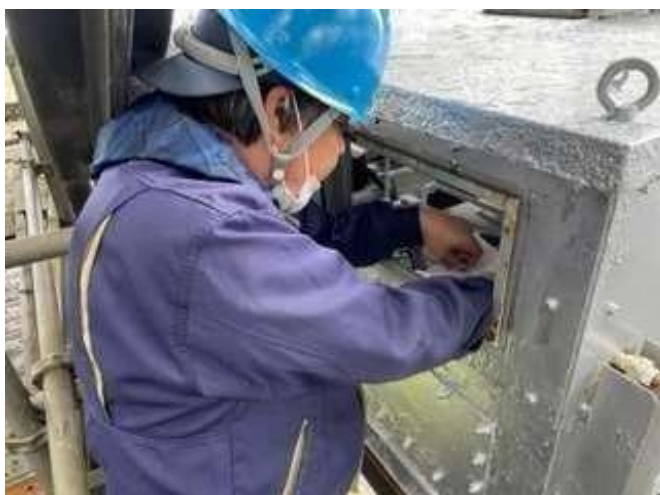
6-9 制動装置油圧ユニット点検
