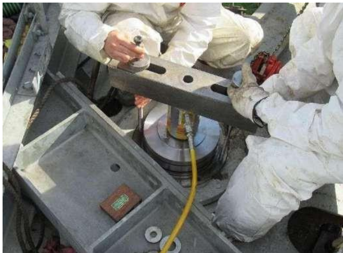
2-7 油圧機器を用いてベアリングを圧入する
