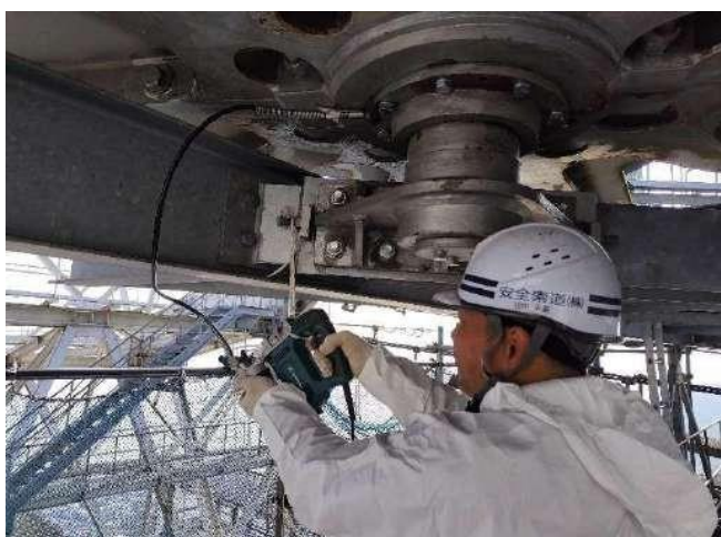
2-11 交換作業完了後、給油作業を行う
