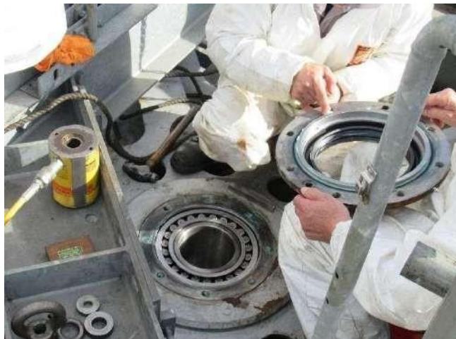
2-8 オイルシールの入ったベアリングカバーの取付準備
