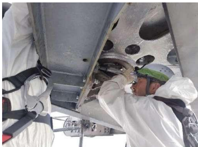
2-11 交換作業完了後、給油作業を行う
