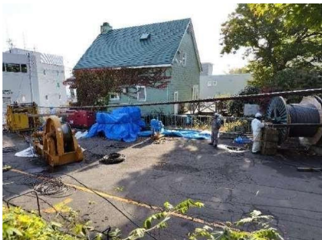
1-9 スプライスの編み込み作業
