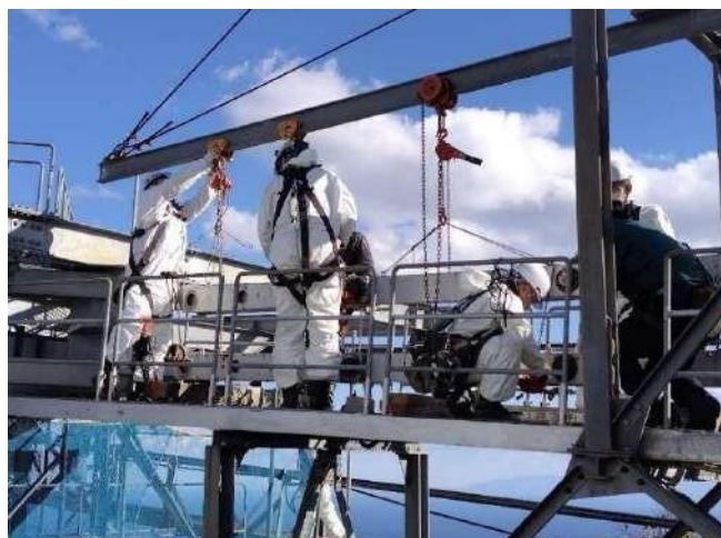
1-12 ロープ交換に伴い、えい索緊張用リンクの長さを調整
