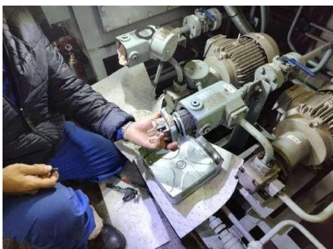
6-9 制動装置油圧ユニット点検
