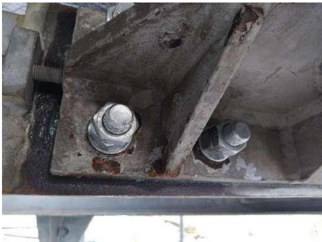
2-10 軸受け部の取付ボルトには、発錆防止のため 溶融亜鉛メッキ加工されたボルトを使用した
