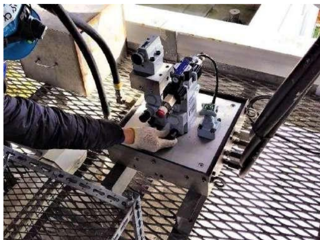
6-10 作動油に窒素ガスが混入する症状がみられたため 次年度はアキュムレーター(赤枠)の整備を実施予定
