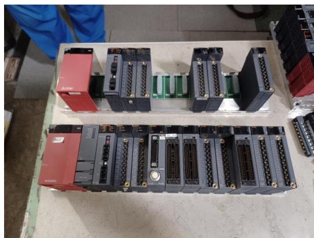
2.31 取り外した電源ユニット
