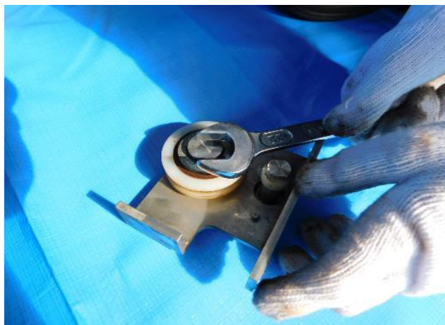
7.11 戸車交換(ベアリング不良、片減りのため計2個交換)
