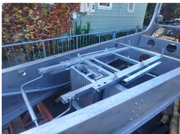
2.16 組立て作業完了
