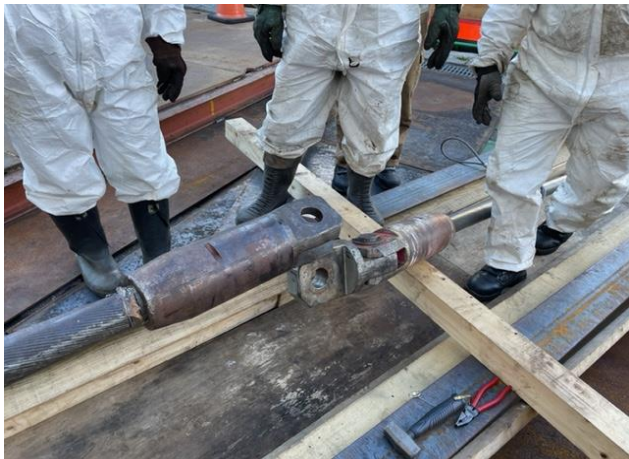
1.7 新旧支索ソケット連結作業
