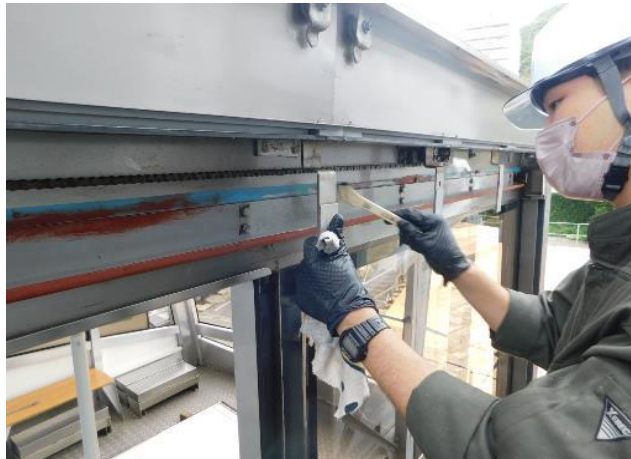
7.4 自動扉上部レール(1号車)
