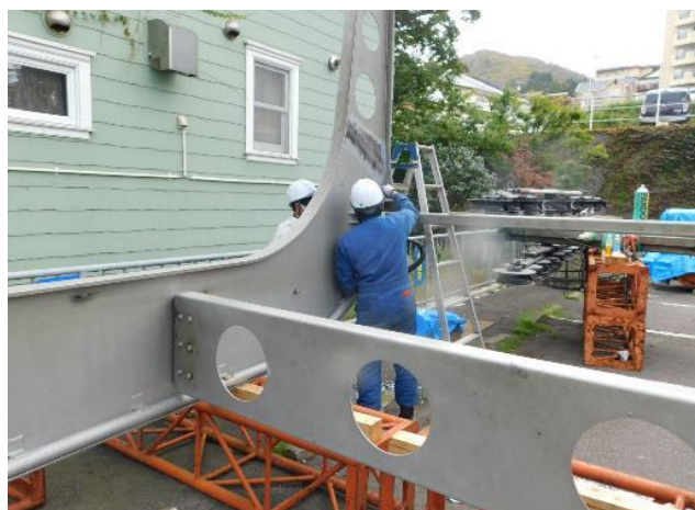
2.3 溶接点検部の塗装剥がし
