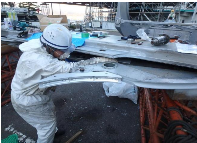
2.1 圧索子交換後キャリア組込み作業
