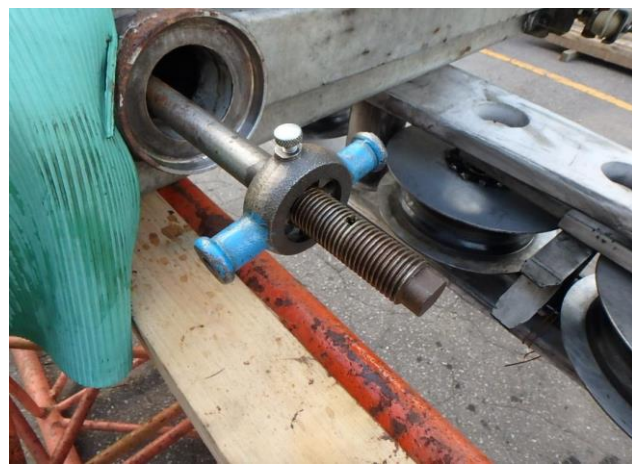
2.10 ロッド取り外し作業②
