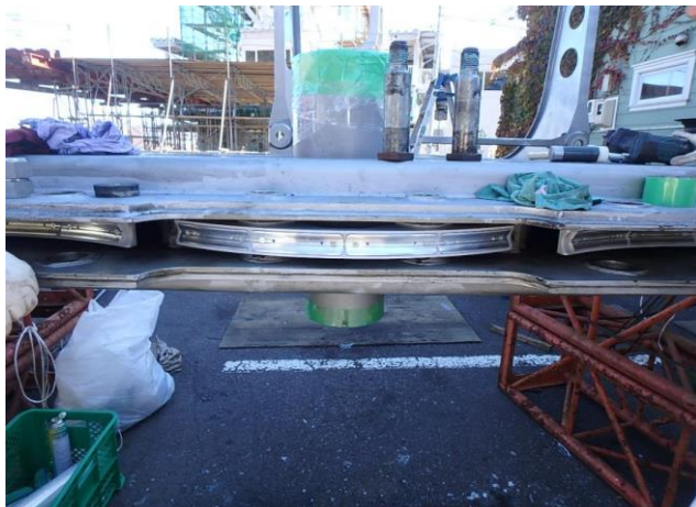
2.2 組込み完了後
