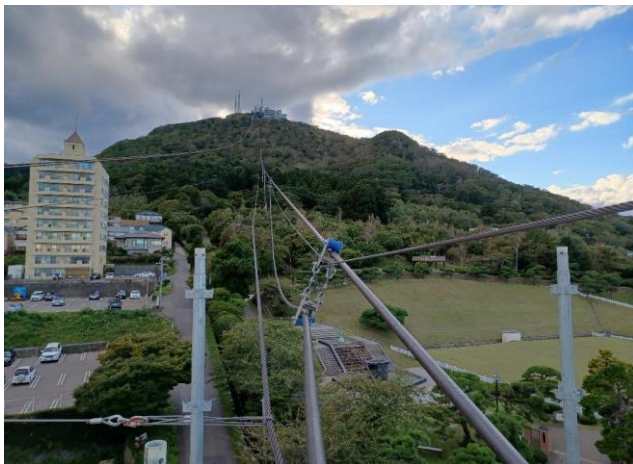
1.10 支索吊金車で片側の支索を吊り山頂に送り込む
