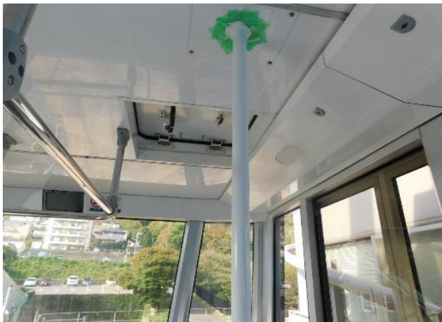
7.3 搬器(吊柱、天窓枠)
