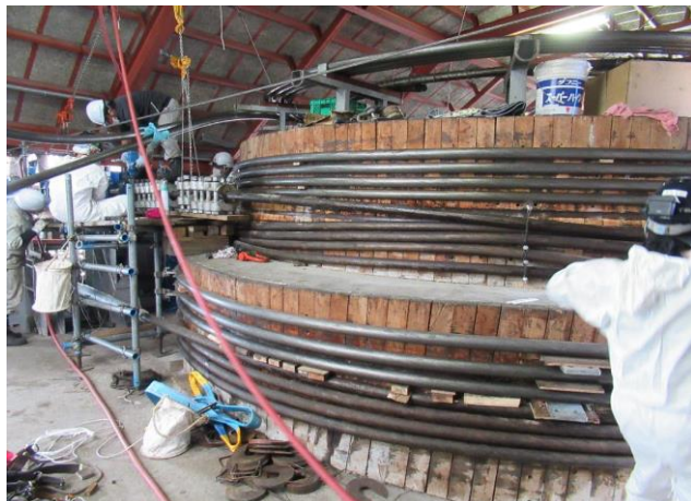
1.12 新支索を山頂碇礎に巻き付け作業
