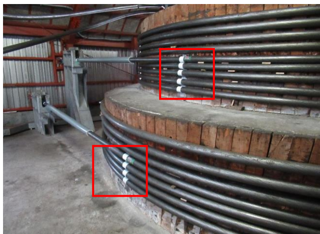
1.15.1 交換後のズレ確認の為、各所にマーキングする
