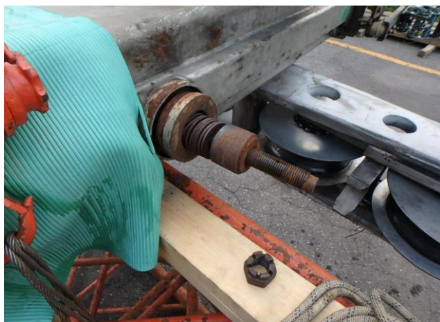
2.9 ロッド取り外し作業①
