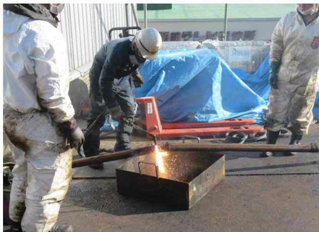
1.13 送り込まれた旧支索の切断作業
