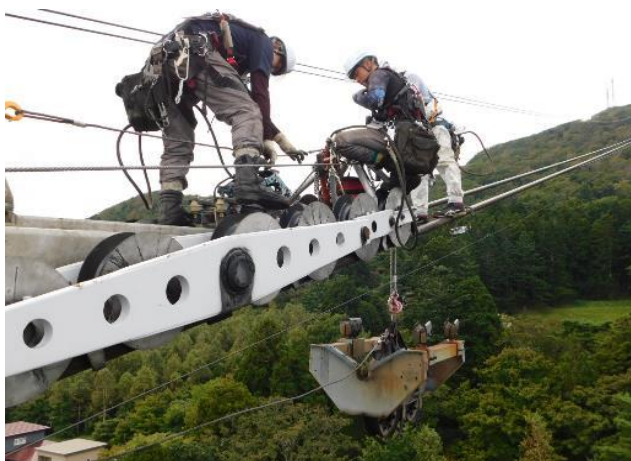
1.21 取り外し作業
