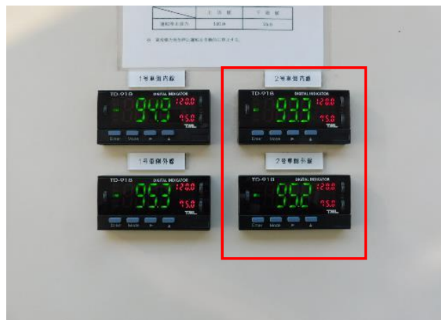
1.20 更新した支索デジタル張力計(2号側赤枠)
