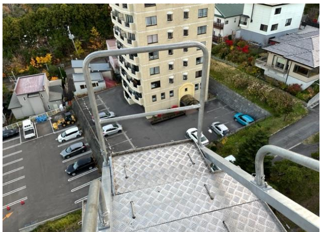
2.17 現場での点検台展開
