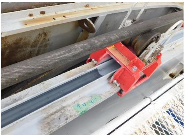
1.36 ナイロン取付け作業
