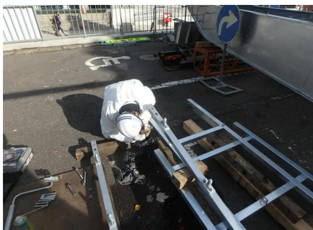
2.15 骨組み組立て作業
