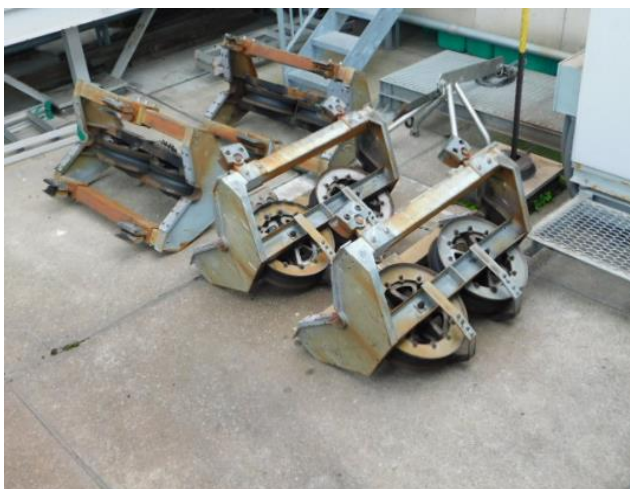
2.34 1号側懸吊器更新(取り外した旧懸吊器)
