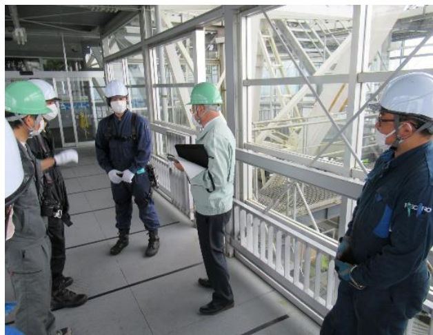
7.22 安全講習受講② フルハーネス使用箇所確認
