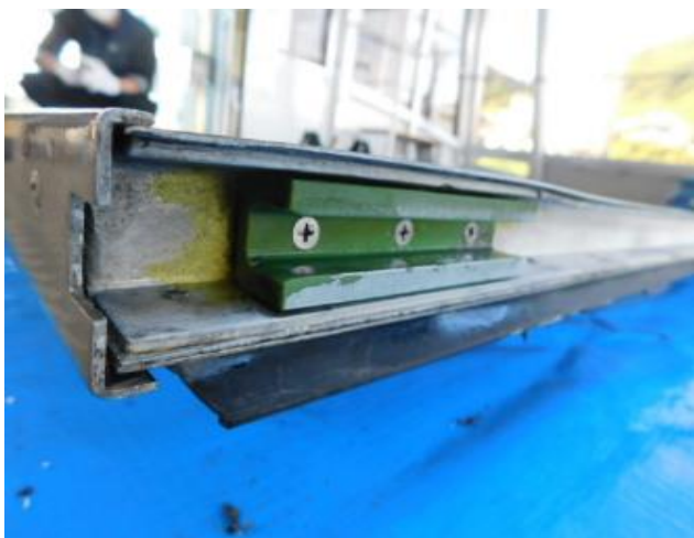
7.13 搬器自動扉点検(扉下部ガイド調整)
