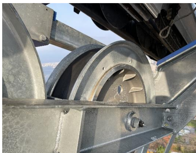
1.24 新懸吊器取付(支索交換完了)
