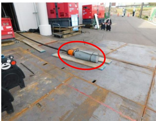
1.9 既設支索ワイヤーロープの山麓側端部を取り出し 固定解除する
