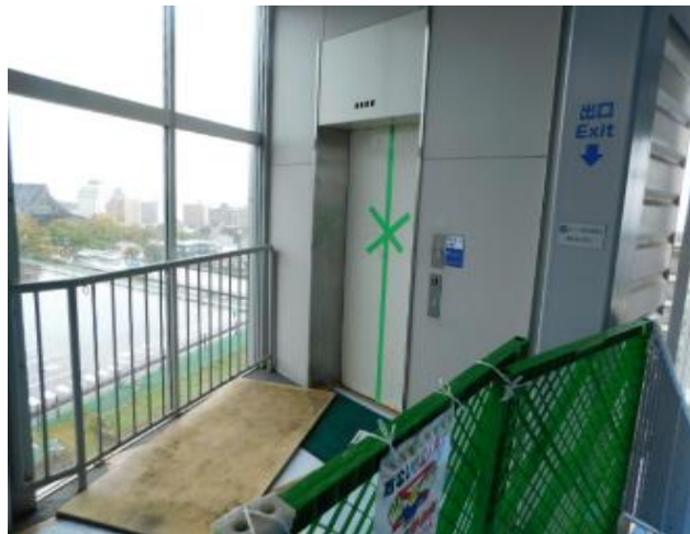
8.2 山麓エレベーター更新(降車側)
