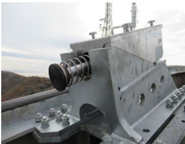
2.29 1号側碇着ダンパー更新(作業効率改善対策) コンパクトになり、受索輪の交換作業効率アップ
