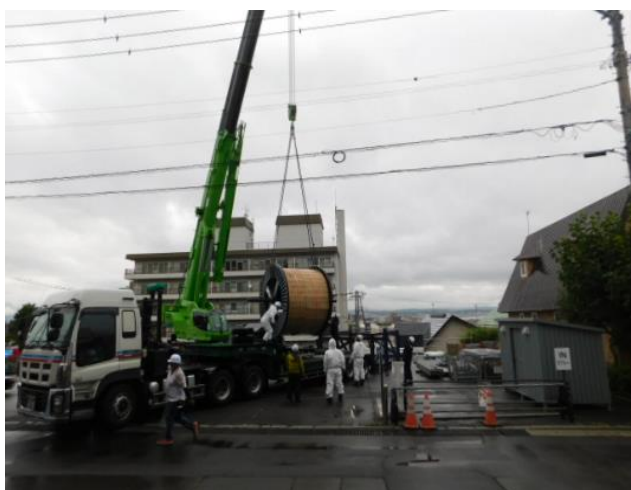
1.7 交換用の新支索ワイヤーロープ搬入
