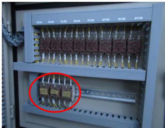
2.27.2 移動棧橋盤改造(右扉裏側へ3個追加)②
