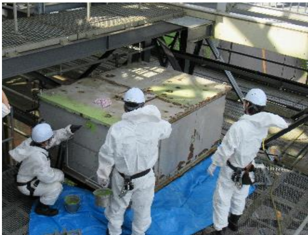
7.3 山頂せり橋油圧ユニット塗装(錆止め)
