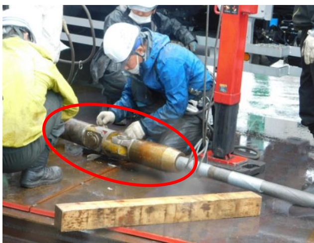
1.11 新旧ワイヤーロープ端部をソケットで固定し ジョイントする
