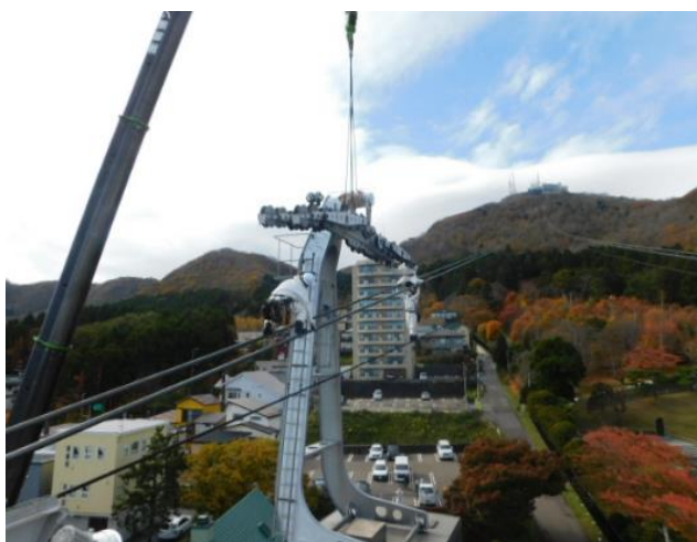
1.23 搬器を線路上へ戻す
