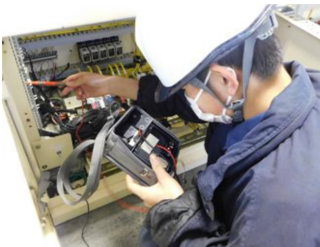
2.19 制御装置保守点検(山頂監視盤)
