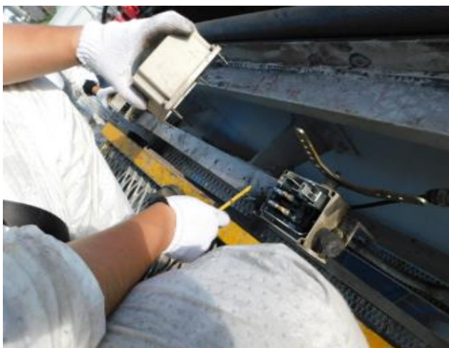
7.11 保安リッター点検(内部結露、腐食等確認)
