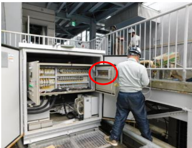
2.27.1 移動棧橋盤改造(無接点リレーへ交換)①
