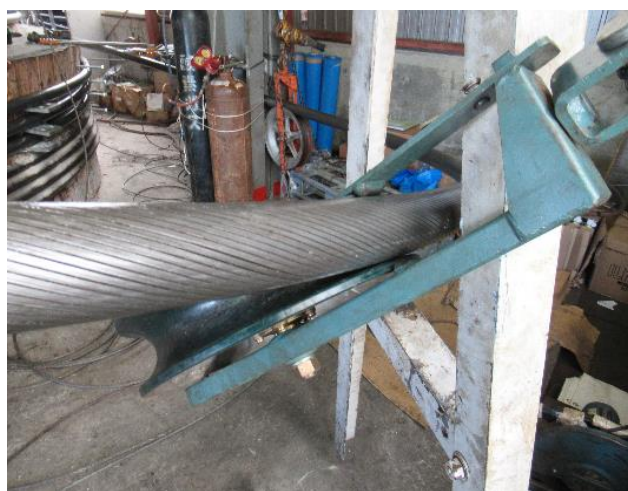
1.22 山頂側碇礎新ワイヤーロープ巻き付け
