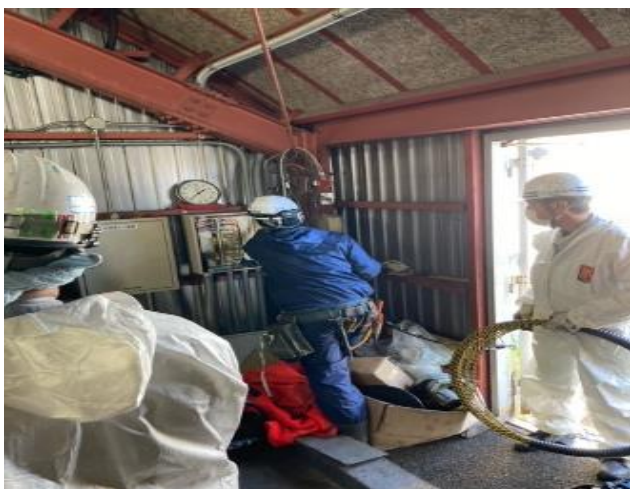
2.11 山頂ケーブル更新(北弘電社)(碇礎～監視盤)
