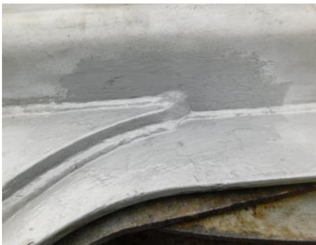
2.28.9 キャリアフレーム点検部塗装①
