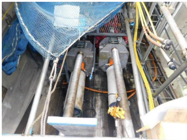
1.21 山麓支索張力調整、二重安全復旧
