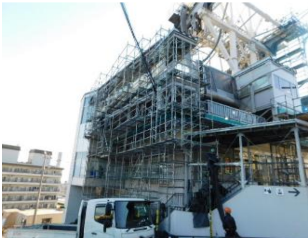
8.1 山麓2号外側プラットホーム
