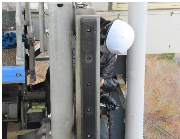
7.6 山頂せり橋移動枠清掃、清掃、給油
