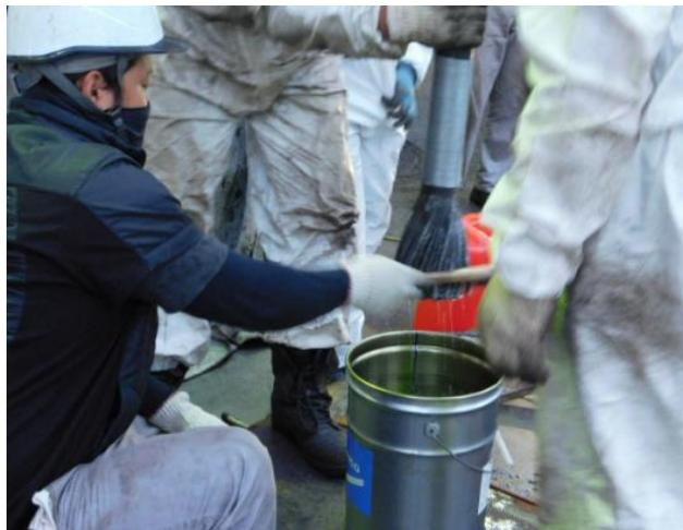
1.18 山麓側支索端部の洗浄と処理
