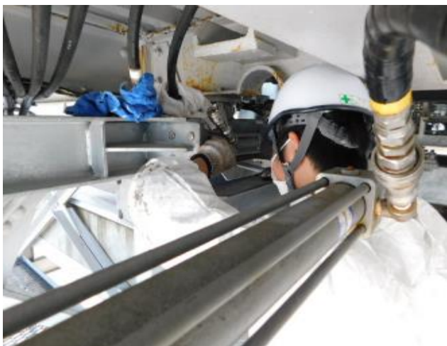
7.9 山麓せり橋点検(油圧シリンダー)
