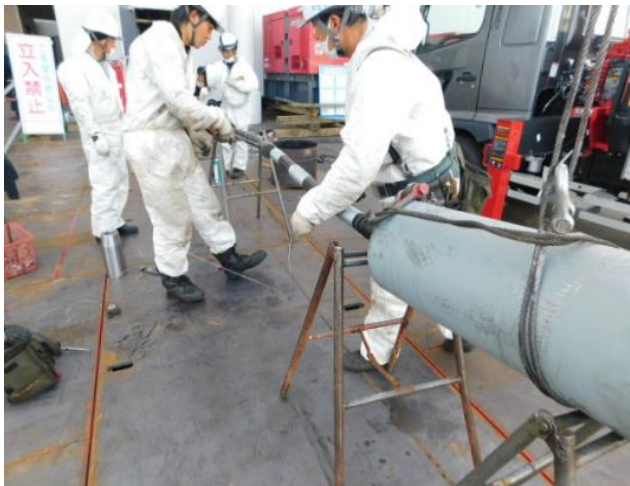
1.17 山麓側支索端部固定用ソケット取付時の素線加工
