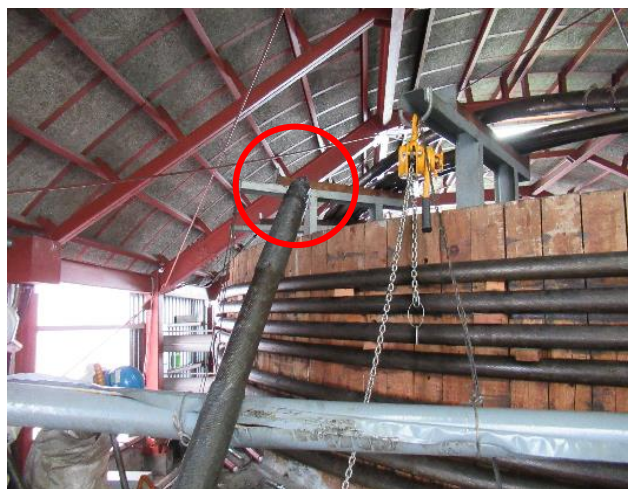
1.10 既設支索ワイヤーロープの山頂側巻き付け部の 固定解除する
