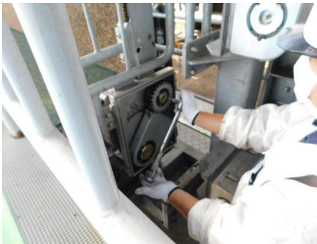
7.5 山頂せり橋点検(適正トルクで増し締め、 ギア清掃、給油)
