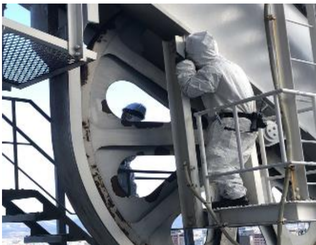
7.15 誘導輪錆取、塗装
