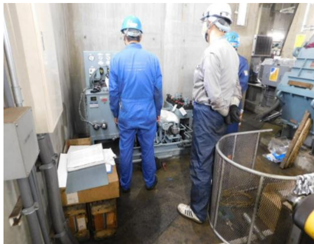
3.6 制動機油圧ユニット点検
