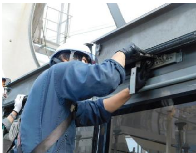
7.12 搬器自動扉点検(駆動チェーン調整)
