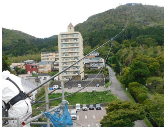
1.12 ジョイントした新旧ワイヤーロープを山頂へ送る
