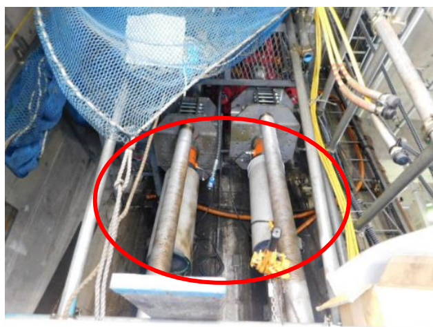
1.8 既設支索ワイヤーロープの山麓側取付端部
