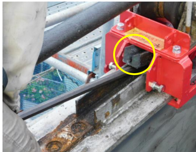
1.16 山麓側支索シューナイロンの除去作業
