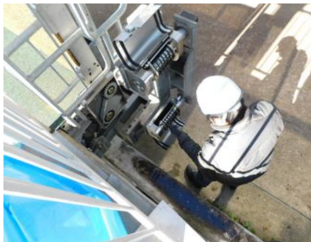
7.10 山麓せり橋緩衝器点検(増し締め、給油)
