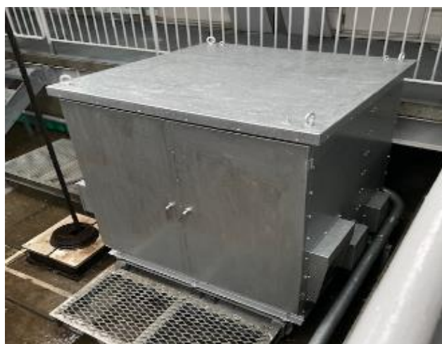
7.18 山麓せり橋油圧ユニット錆取、塗装
