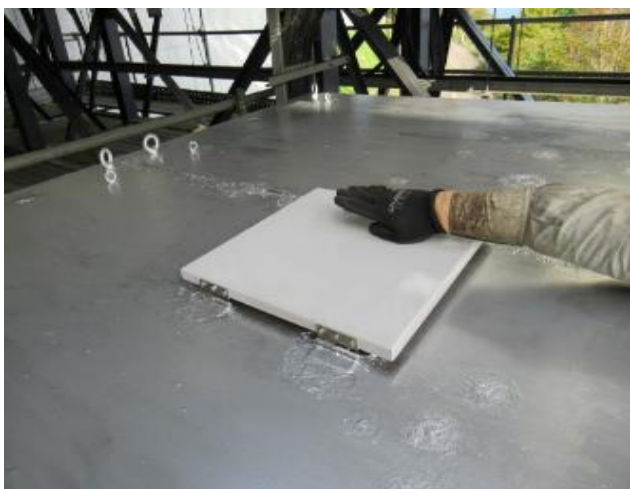
2.23 山頂せり橋油圧ユニット小窓交換(錆が進行していた)
