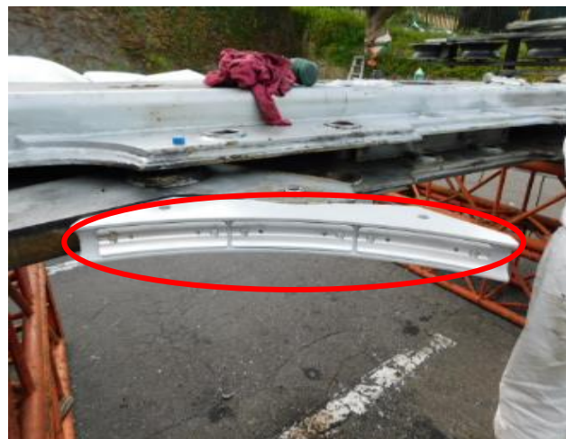
2.10 交換後の上側握索子(アルミ張替え済み)
