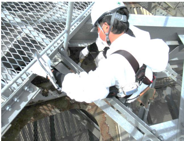
7.7 緊張滑車塗装(錆取り)
