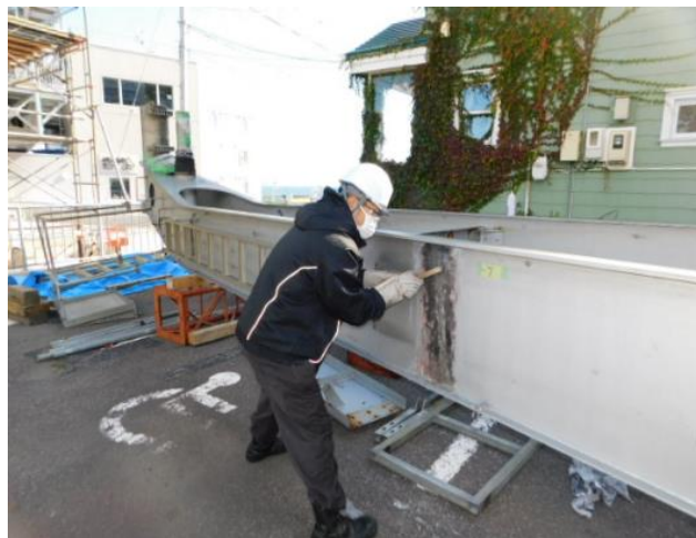
2.28.2 点検部塗装剥がし(ハンガー)
