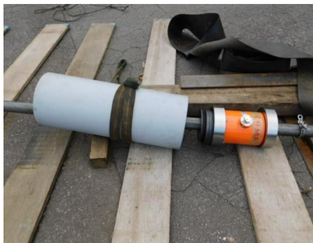
1.20 山麓側支索をソケットケース組込み加工完了
