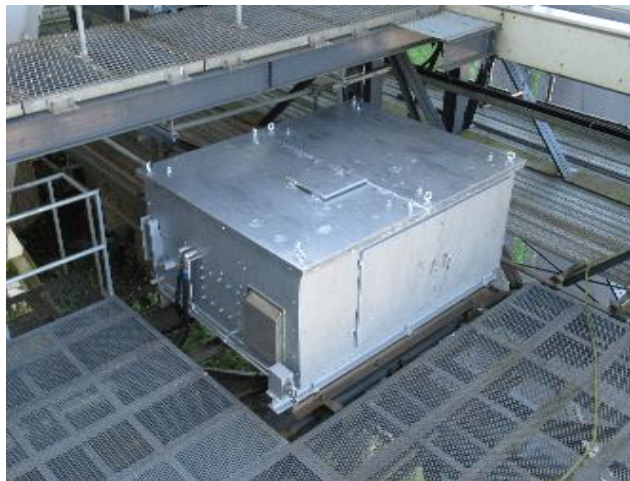
7.4 山頂せり橋油圧ユニット塗装
