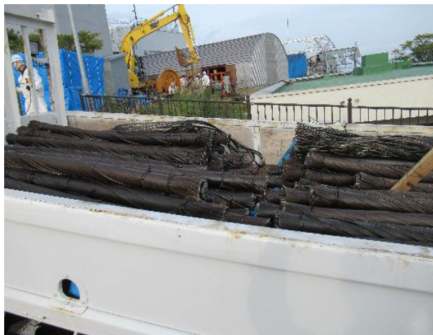
1.14 山頂側で旧ワイヤーロープ回収し切断
