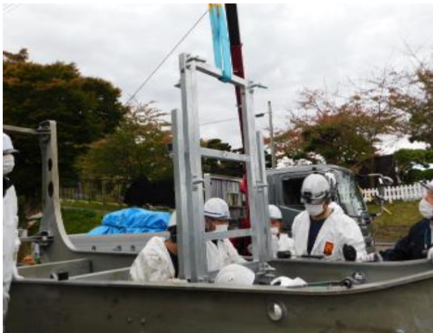
2.1 1号車点検台改造及び懸吊機点検台取付け
