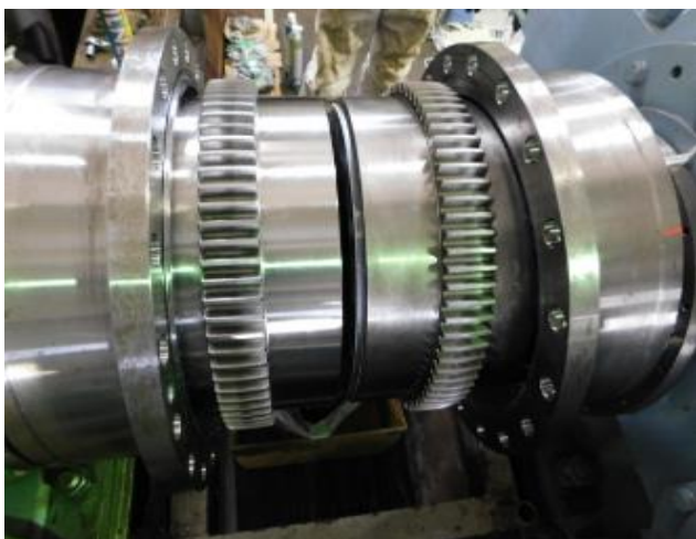
2.25 ギヤカップリング開放点検(モーターと減速機間)
