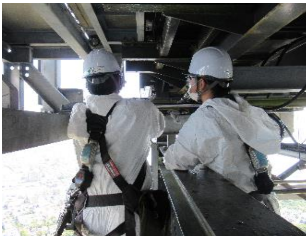
7.1 山頂せり橋油圧シリンダー点検(増し締め)
