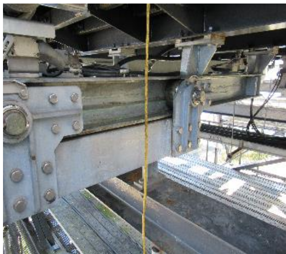
10.8 せり緩衝器ゴム固定ボルトへロックタイト塗布
