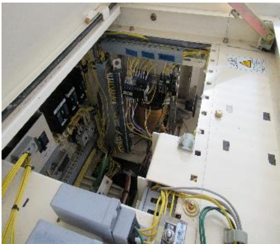
3.3 通信ケーブル制御盤内切替箇所
