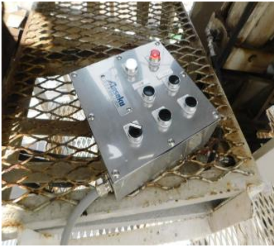
2.3 クランプ油圧シリンダー操作ペンダント更新
