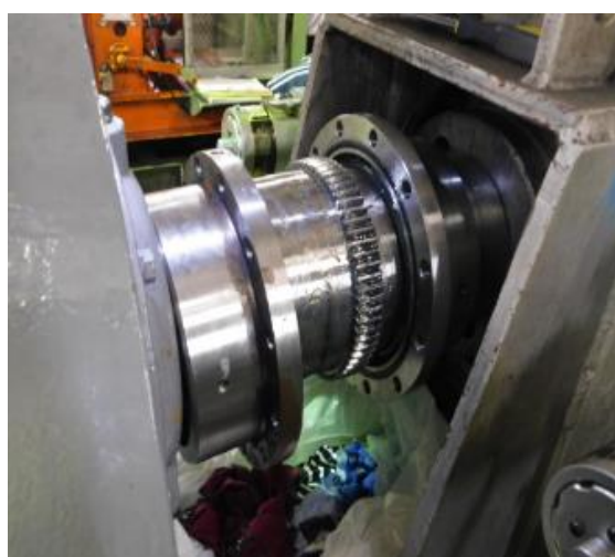
1.10 ギヤカップリング開放点検(モーターと減速機間)
