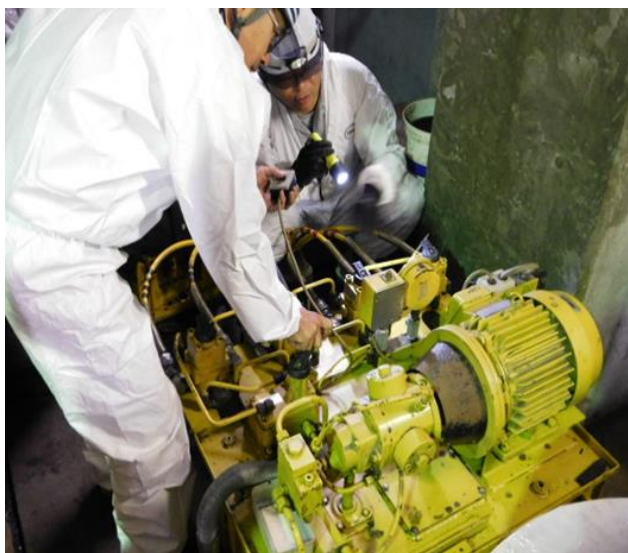
1.5 支索引締め装置動作確認
