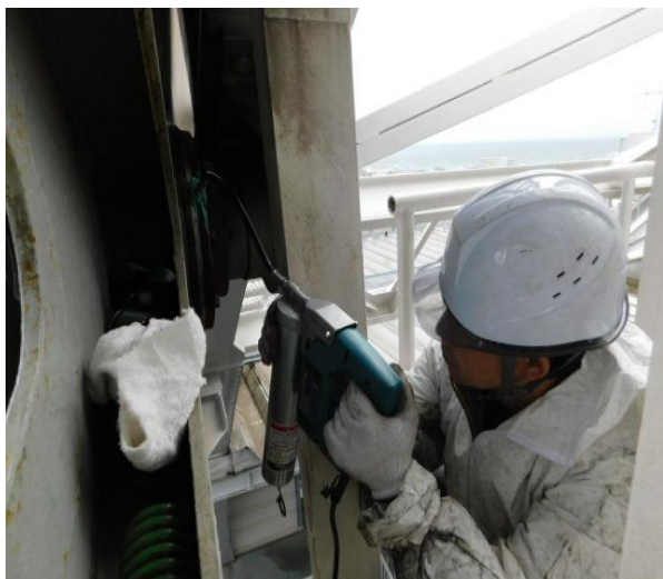
11.9 搬器内床リベット補修
