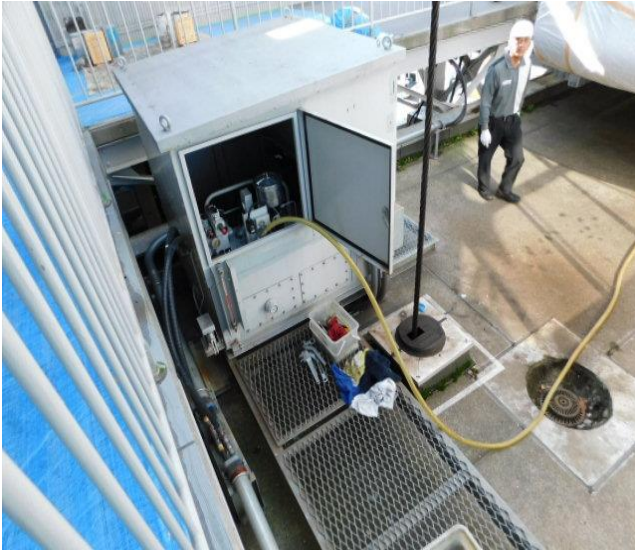
9.1 せり橋オイル交換
