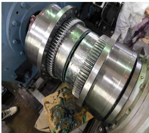
1.6 ギヤカップリング開放点検（モーターと減速機間）
