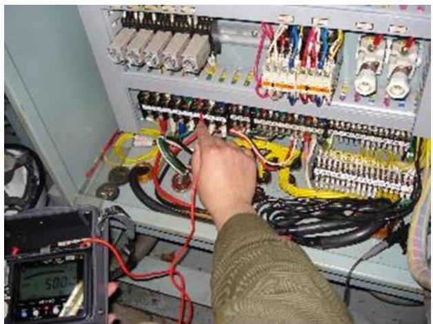
12.15 接地抵抗測定、えい索緊張油圧ユニット盤
